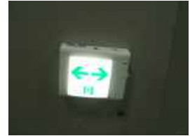
▲ 통로유도등이 올바르게 설치된 경우
